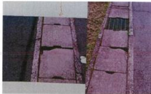
上灘町59番地の側溝床板の修理（中国電力社宅前市道両側）
