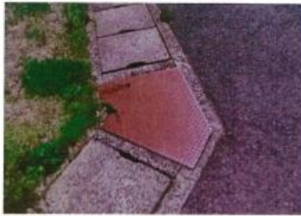
上灘町59番地の側溝床板の修理（中国電力社宅前市道両側）
